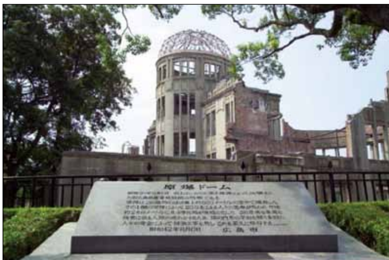
fot. 10. Ruiny żelbetowego obiektu, który przetrwał wybuch bomby atomowej – (fot. Wikipedia)
