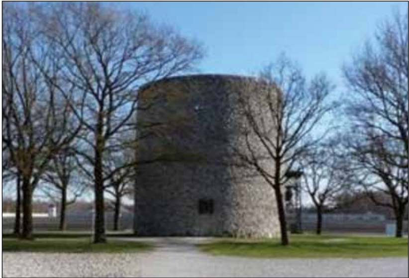
fot. 7. Kaplica w byłego KL Dachau – „Śmiertelnego Lęku Pana Jezusa” – fotografia z artykułu (29)
