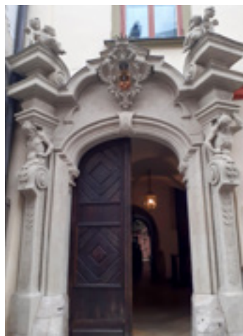
Fot. 2: Portal z atlantami w portalu Pałacu Papielów przy ul. św. Jana 20.
