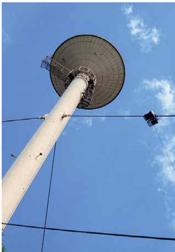
Rys. 27. Badania magnetyczne lin odciągowych wieży ciśnień
