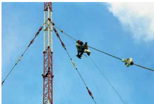
Rys. 26. Badania magnetyczne lin odciągowych masztu radiowego
