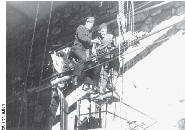
Rys. 9. Montaż głowicy na linę nośną kolei linowej na Kasprowy Wierch
