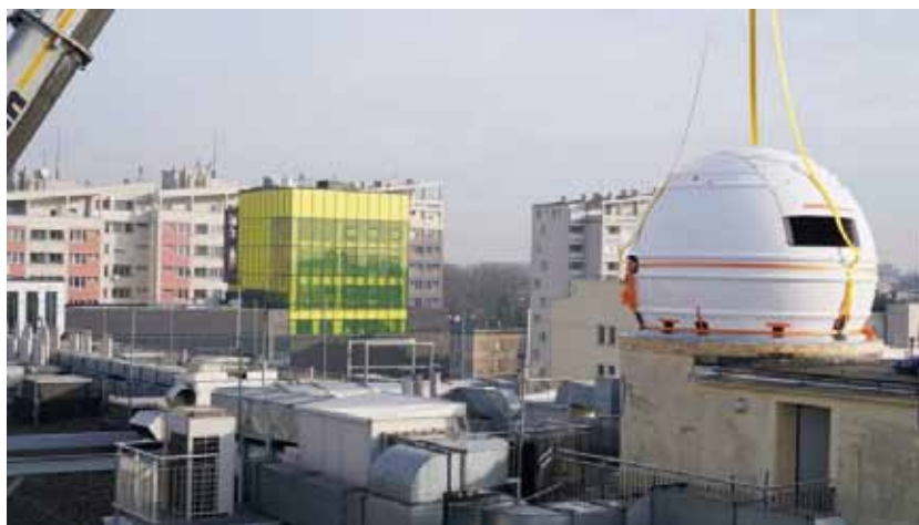
fot. 3 Montaż kopuły obserwatorium na dach budynku C-4
