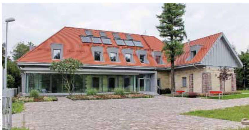
Pasywny budynek Centrum Zrównoważonego Rozwoju i Poszanowania Energii w Miękinii
