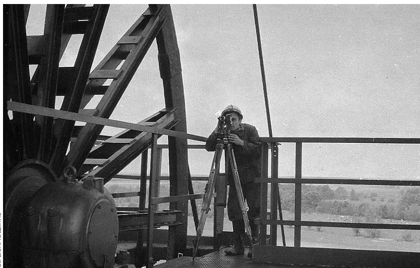
Jan Jurczenko w trakcie wykonywania pomiarów przy ustawianiu górniczej maszyny wyciągowej
