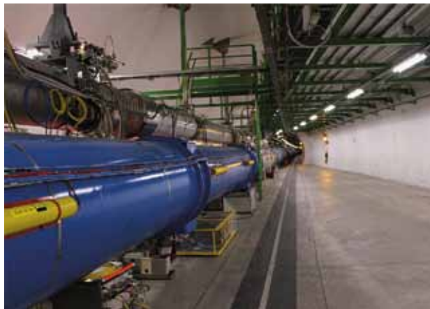
Unikalny szeroki fragment tunelu akceleratora LHC w pobliżu szybu 8, widoczne są linia zasilania kriogenicznego znajdująca się powyżej magnesów dipolowych (niebieski kriostat) oraz blok ochrony magnesów przed przejściami rezystywnymi (żółty panel pod magnesem)
