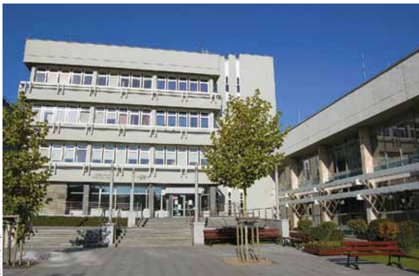
WIMiC – Pawilon B-6, hala technologiczna
