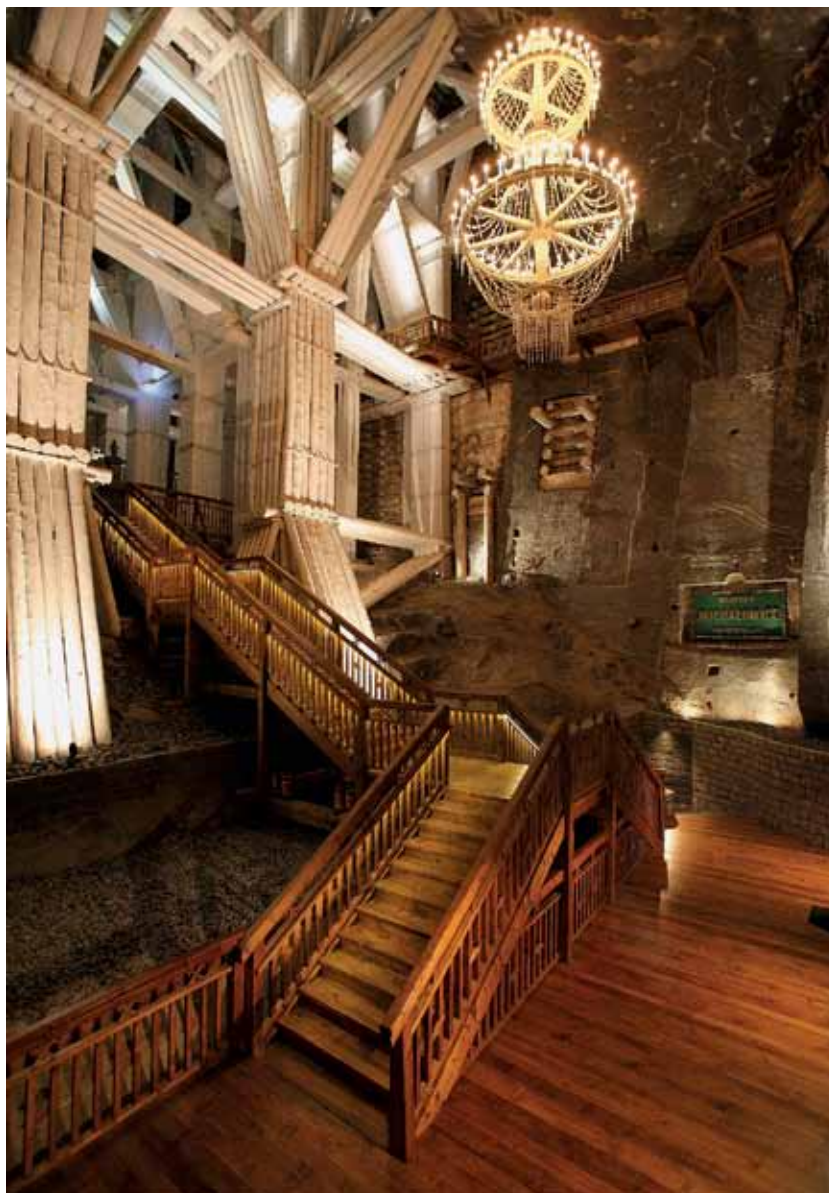
Komora Michałowice. Jej strop sięga I poziomu kopalni (ok. 64 m głębokości), spąg zaś poziomu II niższego (ok. 110 m głębokości). Uwagę zwraca monumentalna drewniana obudowa wsparta na dwóch filarach wiązkowych
